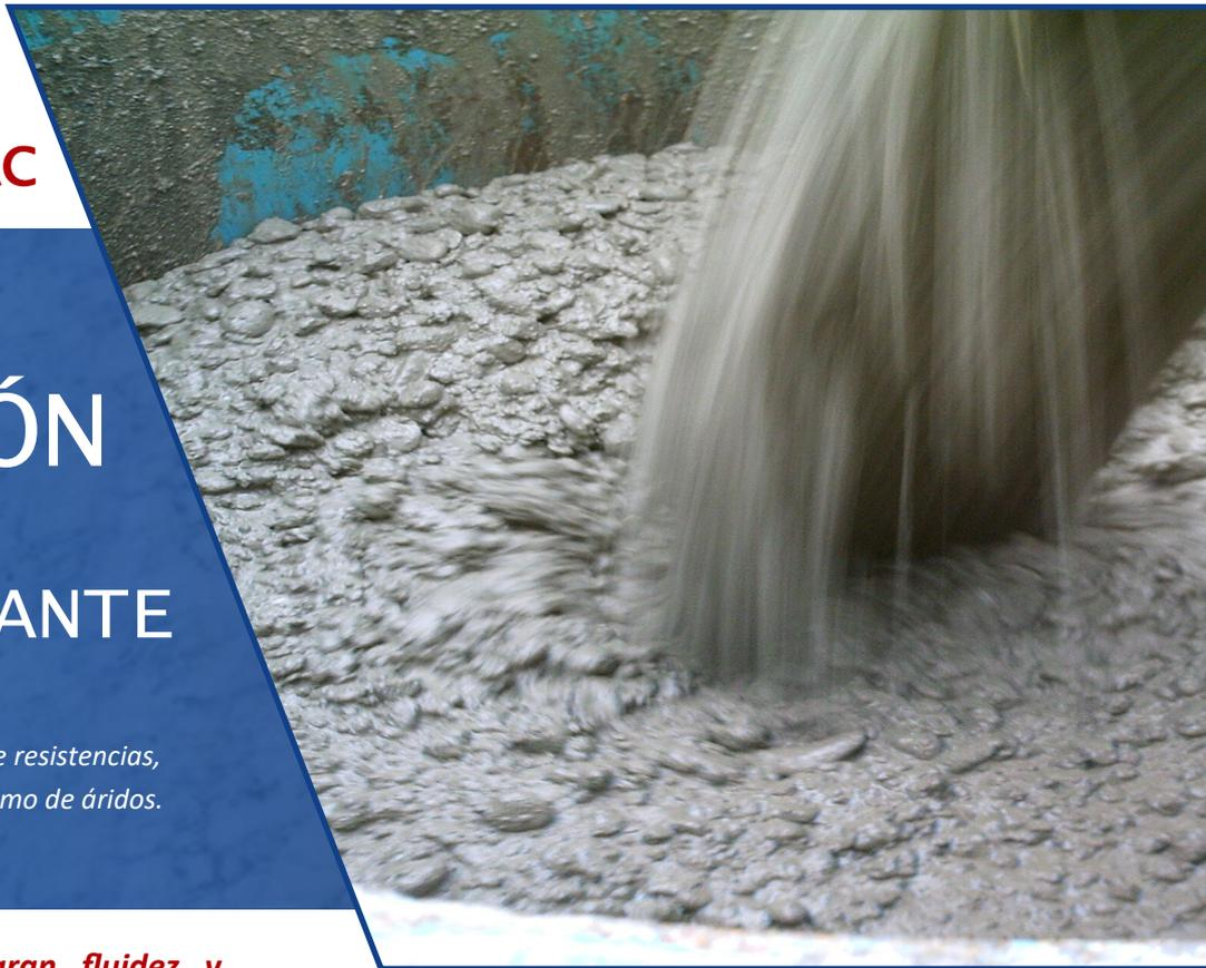
Es un hormigón de **gran fluidez y cohesión** que sin apenas vibrado es capaz de adaptarse a la forma de los encofrados rellenando las zonas más inaccesibles y reduciendo el riesgo de segregación y bloqueo.
