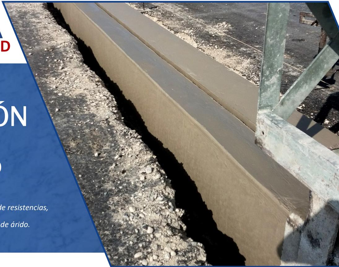
Es un hormigón de consistencia seca y elevada trabajabilidad gracias a la incorporación controlada de aire en su mezcla. Está especialmente diseñado para su uso en máquinas extrusoras, permitiendo ser colocado mediante diferentes tipos de encofrados deslizantes. Permite un hormigonado continuo sin cortes ni imperfecciones adaptándose a la forma del molde y consiguiendo un acabado superficial de gran calidad.
